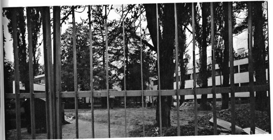
Die Nordwestseite des Wohnheims zum Park (oben: 1929, unten: 1990)
