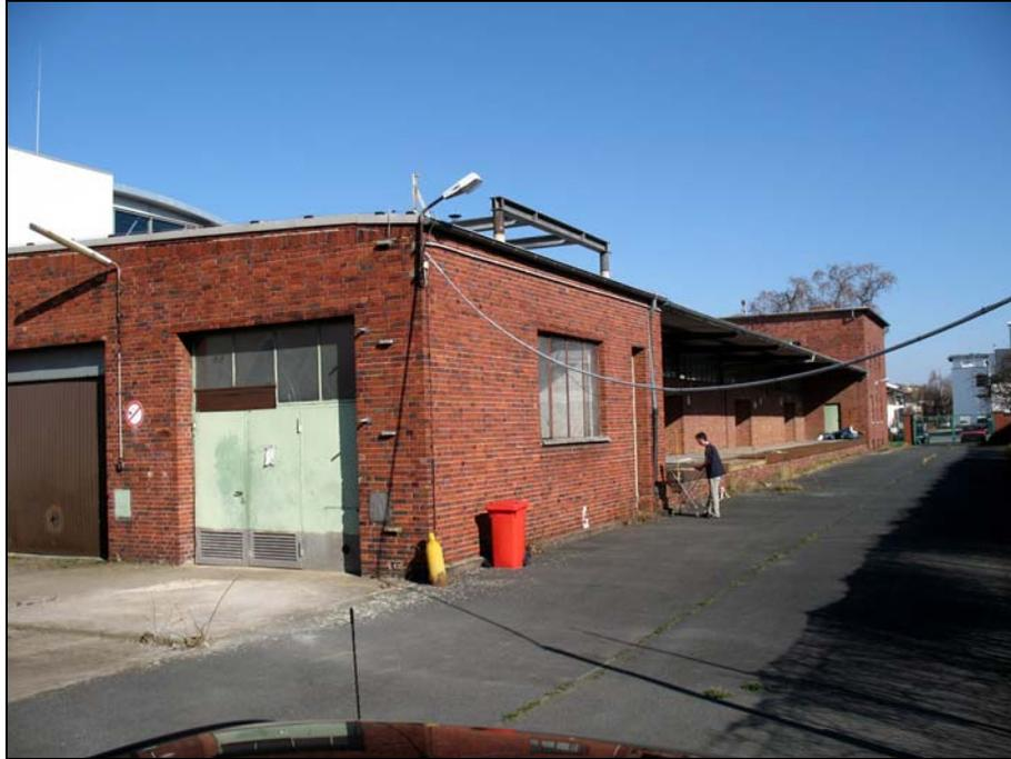
Der Umbau der südlichen Garage zum Pumpenraum ist von außen an dem ersetzten Garagentor zu erkennen. Über die in der Fassade verankerten Steigbügel war eine Wartungsbühne auf dem Dach zu erreichen. Sie gehörte zu dem turmartigen 25000-Liter Sauerstofftank, der vor dem Tor aufgestellt worden ist und auf den nur noch die Betonbodenplatte hinweist.
