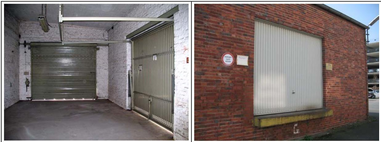
Das Flüssiggaslager in der umgebauten nördlichen Garage mit erhöhtem Fußboden, zwei Toren und Laderampen
