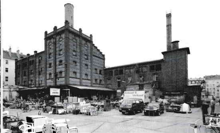
Ehemalige Willner-Brauerei, Bestandsdokumentation 1996–1998
